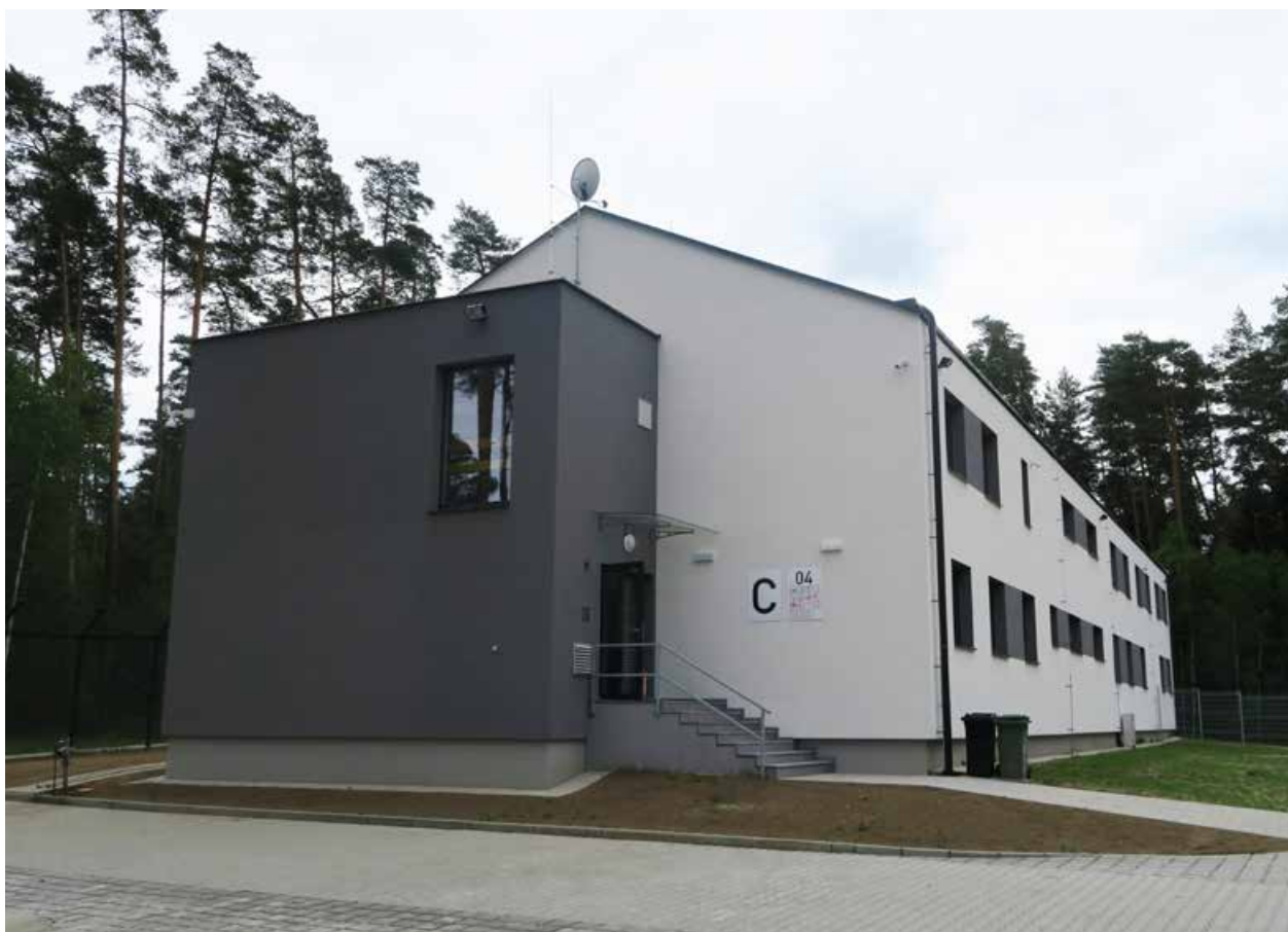
Nově postavená budova „C“ v ZZC Bělá-Jezová
